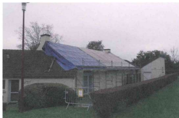
La charpente en cours de réalisation
