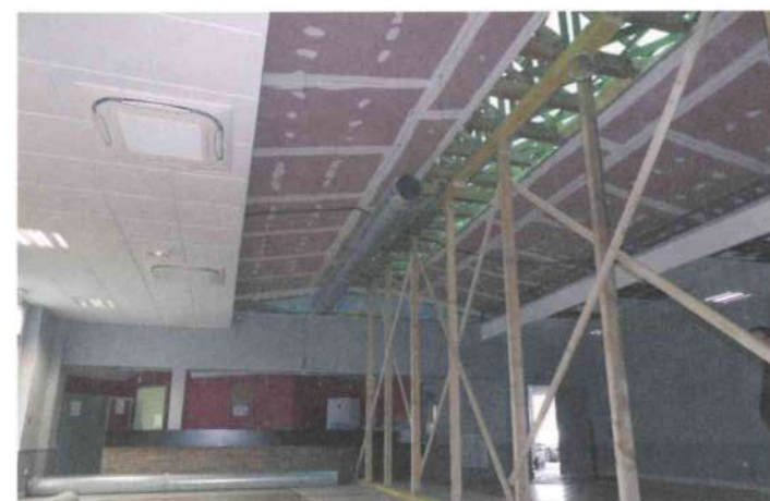
Les plafonds en cours de démolition
